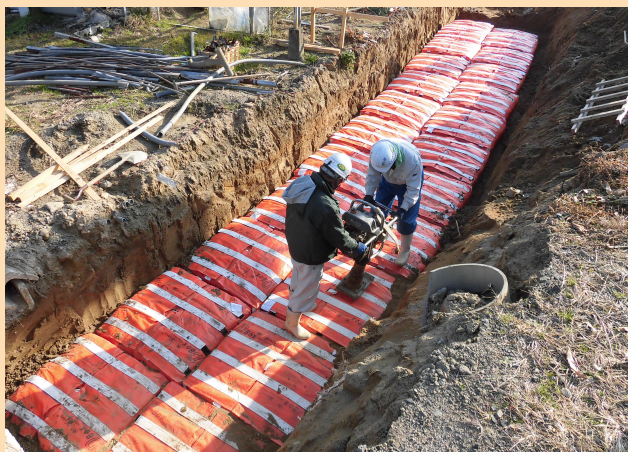
■外圧振動（強制加圧）袋の中の砕石が締め固められ強固な支持を得る
