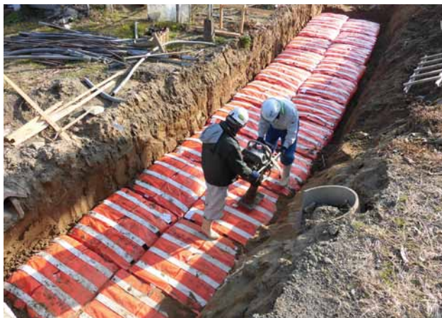
■外圧振動（強制加圧）袋の中の碎石が締め固められ強固な支持を得る
