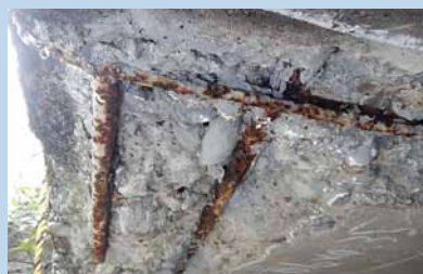
鋼材の腐食膨張によるコンクリートの剥落
