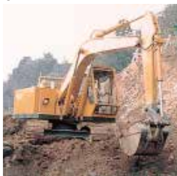
①掘削・整地
