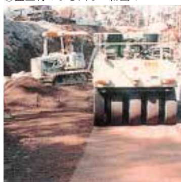
⑤盛土材のまき出し・締固め
