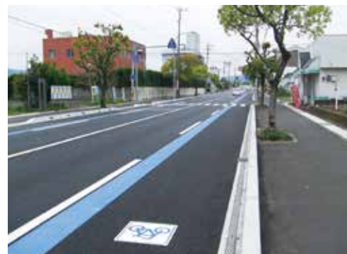
自転車専用レーン施工例
