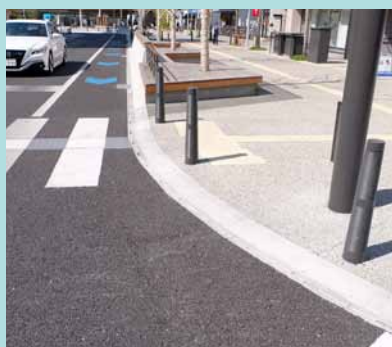
巻き込み部の施工例
