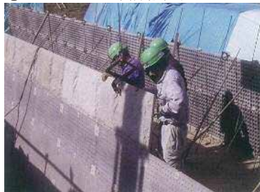
⑤ コンクリート打設状況
