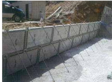
④ 2段目設置完了状況
