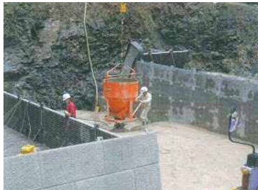
⑤ コンクリート打設状況
