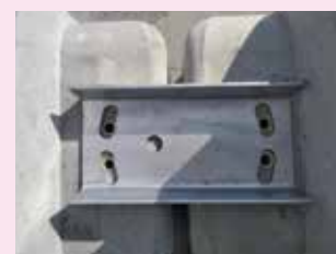
200×80 HDZ55をM20ボルトにて固定
