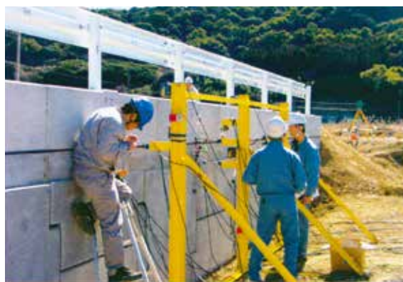
衝突実験前（補強土壁上）
