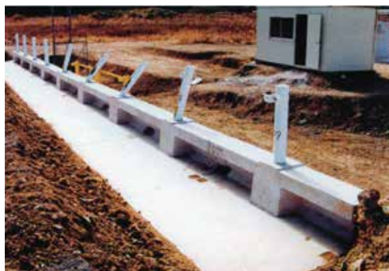
衝突後の状況（補強土壁上）
