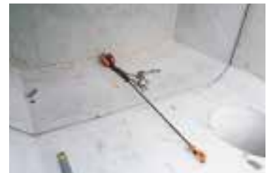
引き寄せ チェーンブロックによりブロック同士を引き寄せます。
