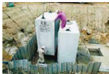
吸管投入孔設置 ブロックにインサートを内蔵しており、ボルトにて固定します。
